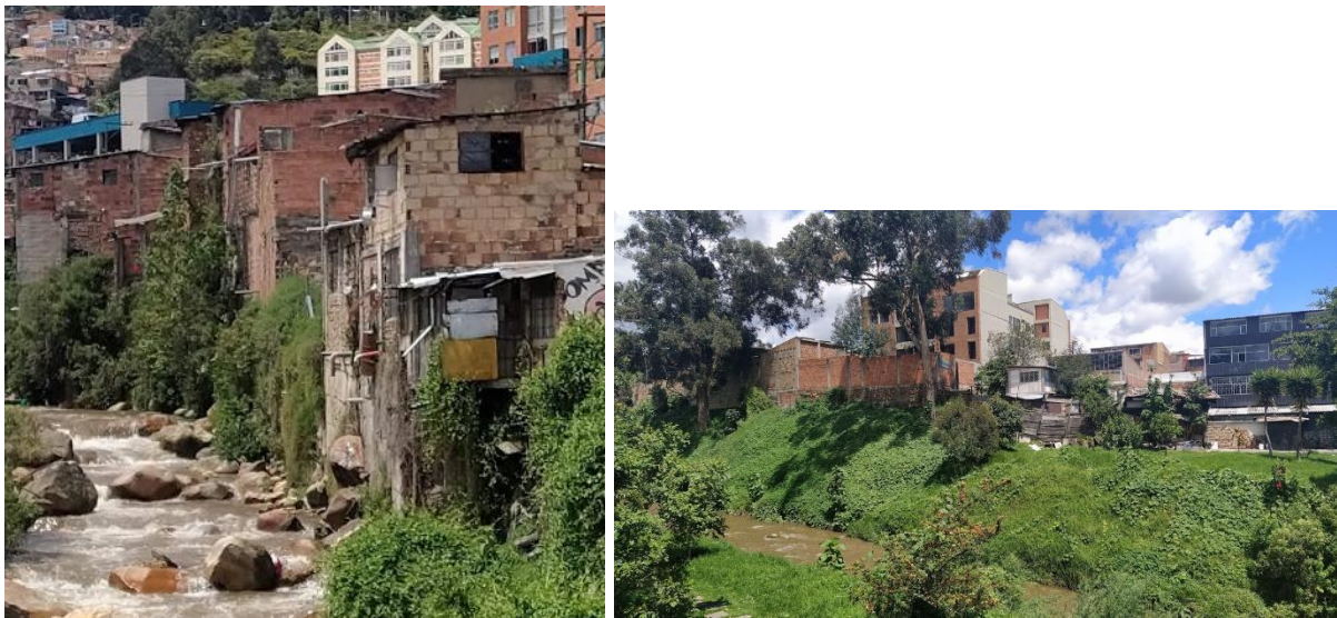
Figura 16. Invasión de la ronda hidráulica.
